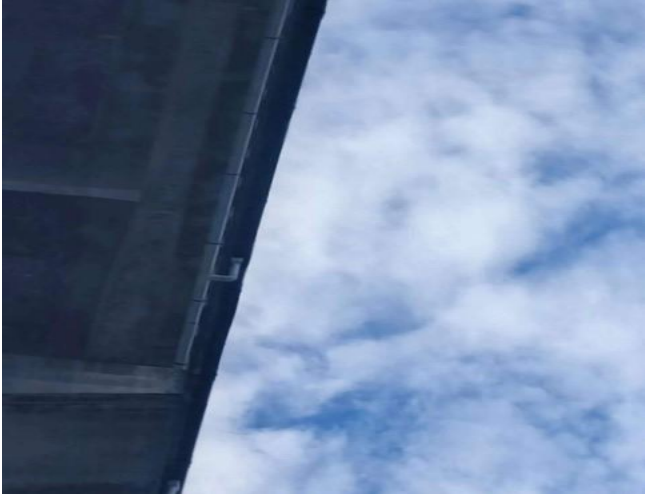
义安大桥排水管图
