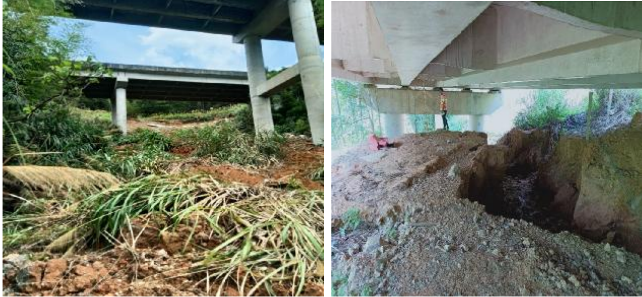
暗头大桥桥底溜方图
